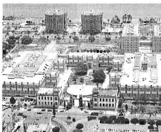
Vista aérea del complejo de Tabacalera.
