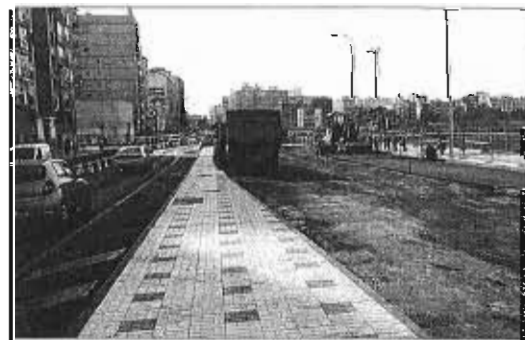
Los trabajos encaran la recta final. LA OPINIÓN
