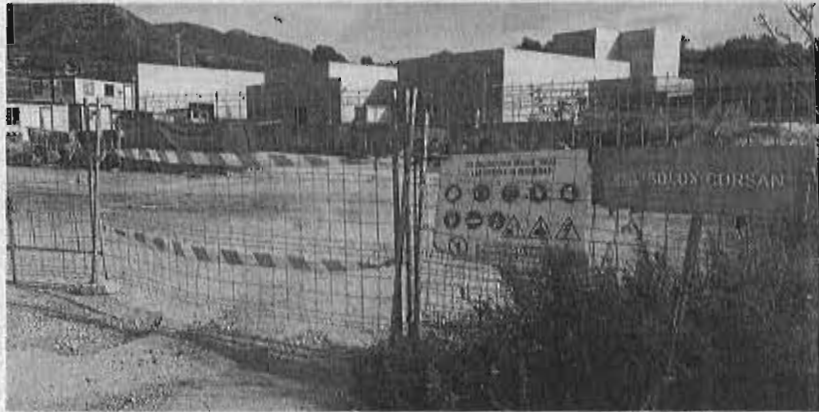
La planta de tratamiento de aguas residuales está prácticamente finalizada, al 96% de ejecución. :: E. CABEZAS
