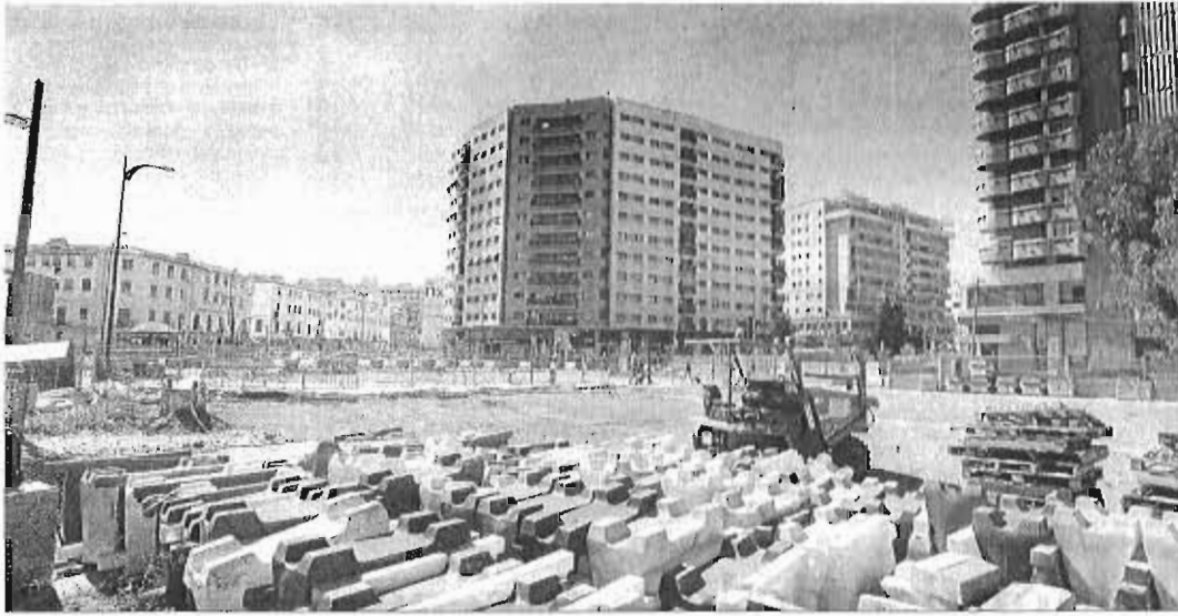
Vista de las obras en la plaza de Albert Camus al comienzo del conflicto con la constructora.
