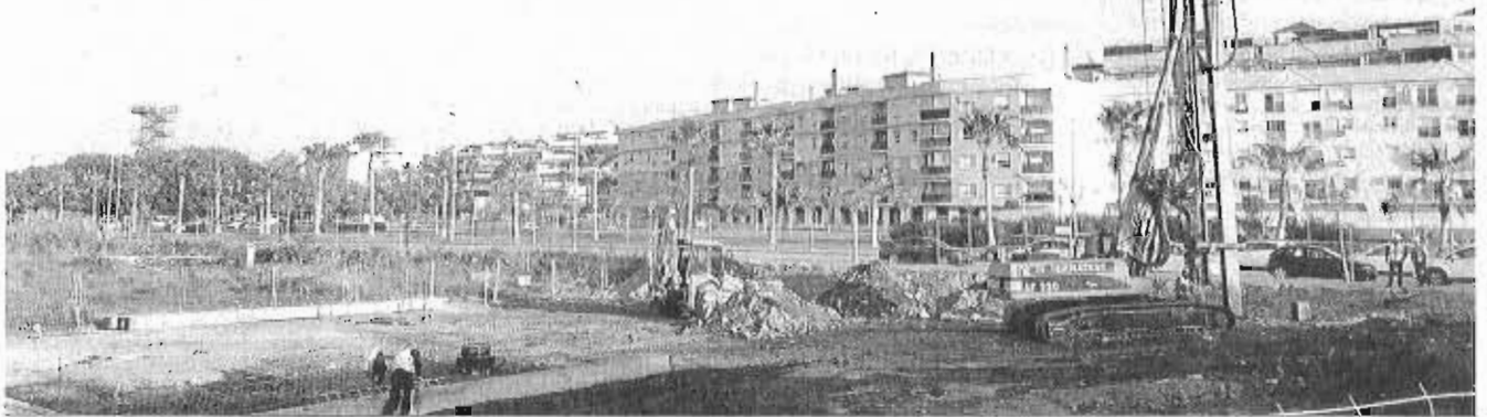
Vista de los trabajos en una obra de viviendas en la capital.
