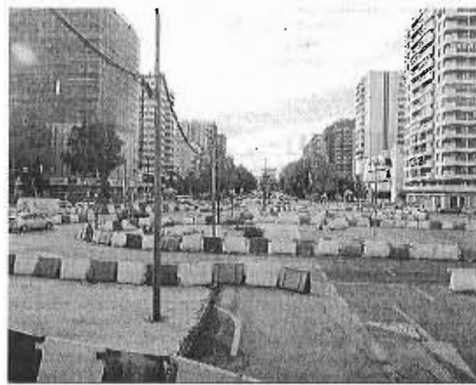
Vista actual del tramo del Metro parado, en la Avenida de Andalucía.
