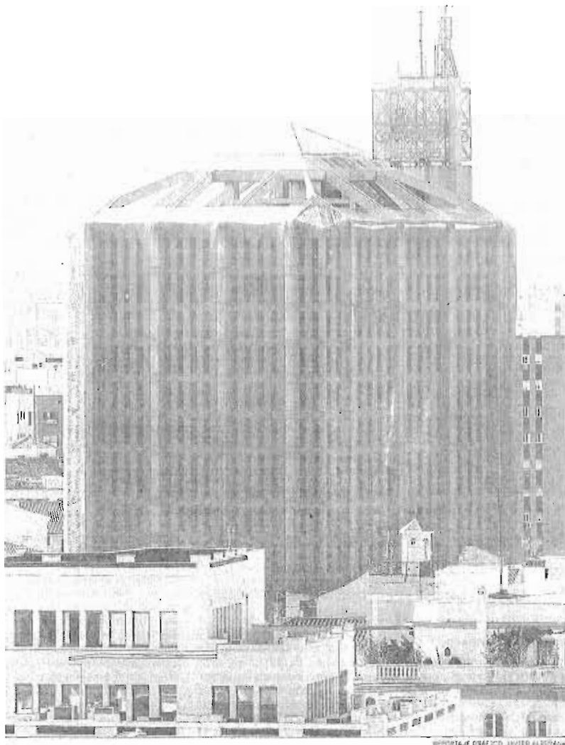
Vista del antiguo edificio de Correos.
