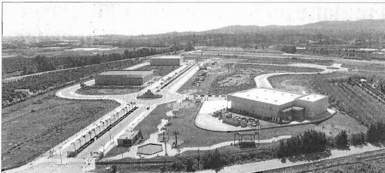
Una vista panorámica de las instalaciones de la gran tecnópolis que se localiza en pleno corazón geográfico de la comarca de la Axarquía. F. E.
