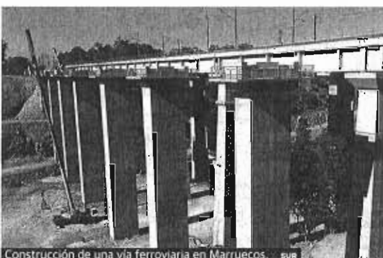
Construcción de una vía ferroviaria en Marruecos. SUR
