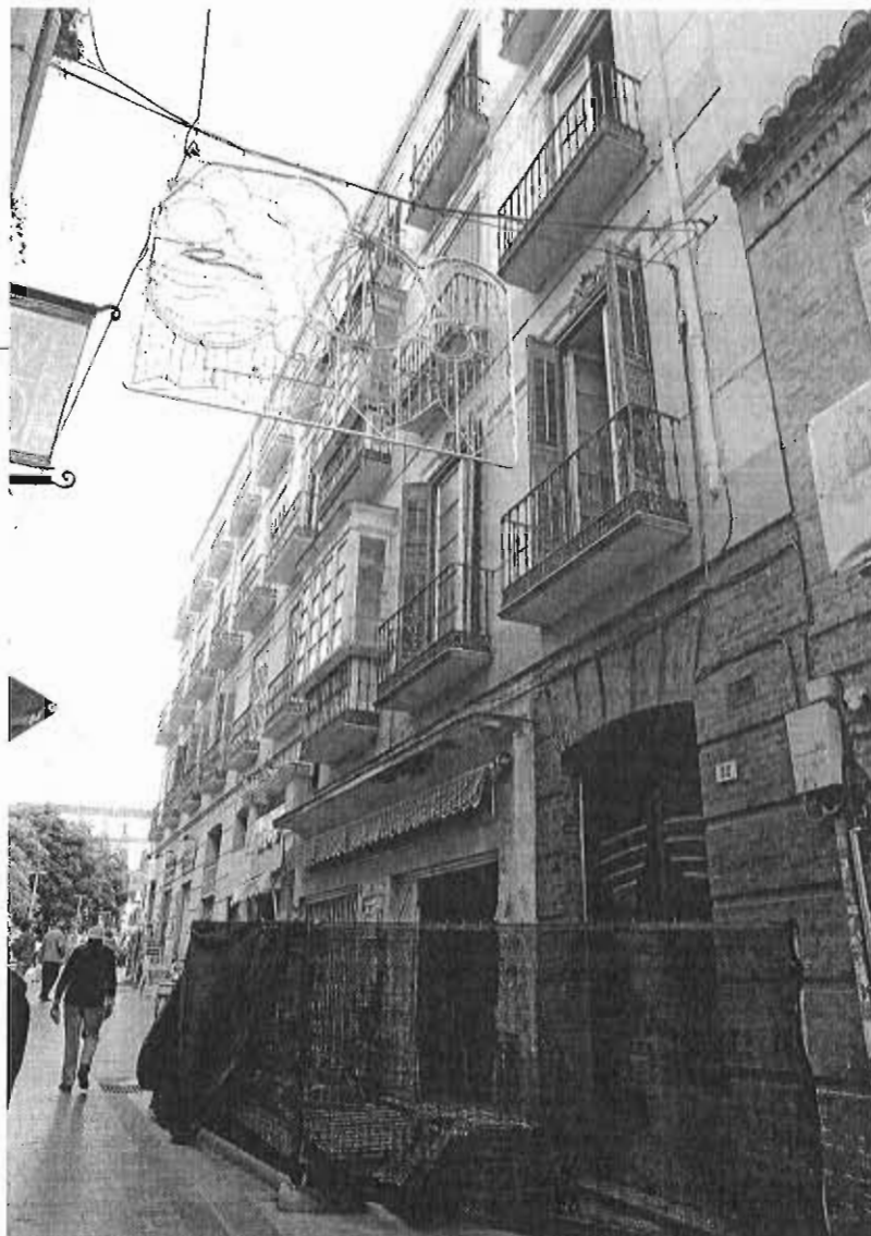
Edificio de la calle Granada en obras para albergar 17 apartamentos turísticos. // SALVADOR SALAS
