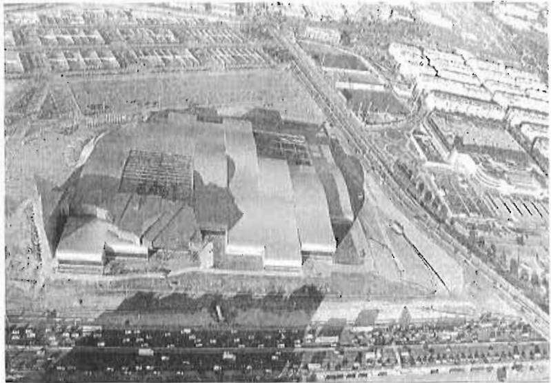
Vista aérea del Palacio de Ferias de Málaga y del intenso tráfico de la ronda oeste.
