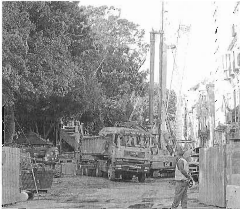
Imagen de archivo de los trabajos del Metro en el lateral norte de la Alameda.
