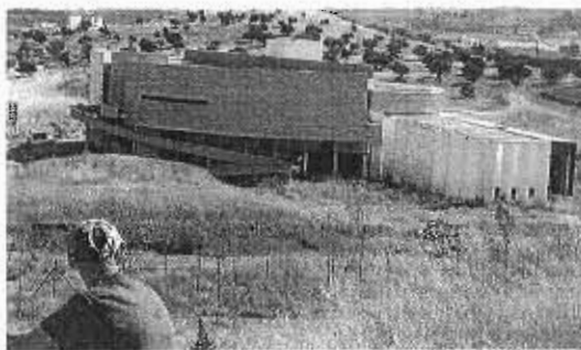
Imagen del centro que será parcialmente demolido. :: SUR
