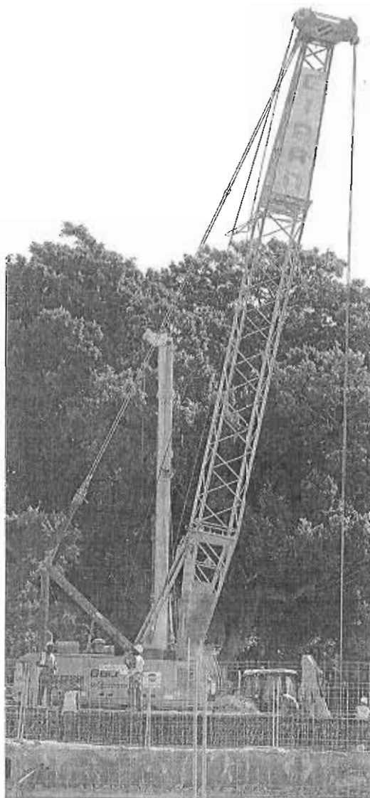
Unas obras del Metro de Málaga en la Alameda Principal.
