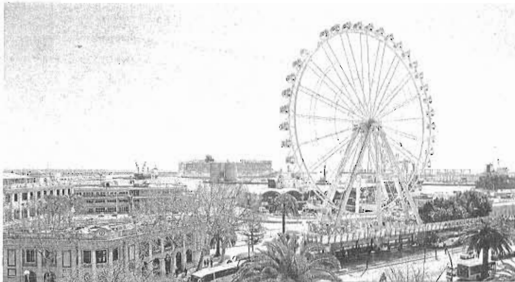
Vista de la noria del puerto y de la entrada al recinto.
