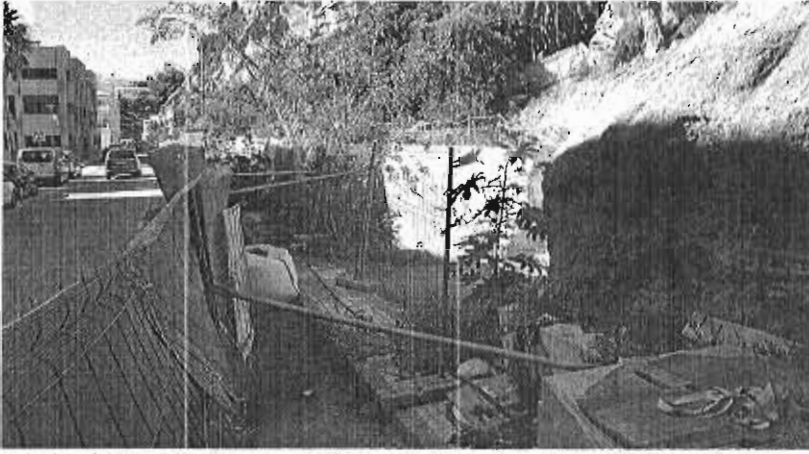
En la playa de Burriana queda por ejecutarse la principal estación de bombeo, el emisario y colectores. ■ ■ ■ ■ ■
