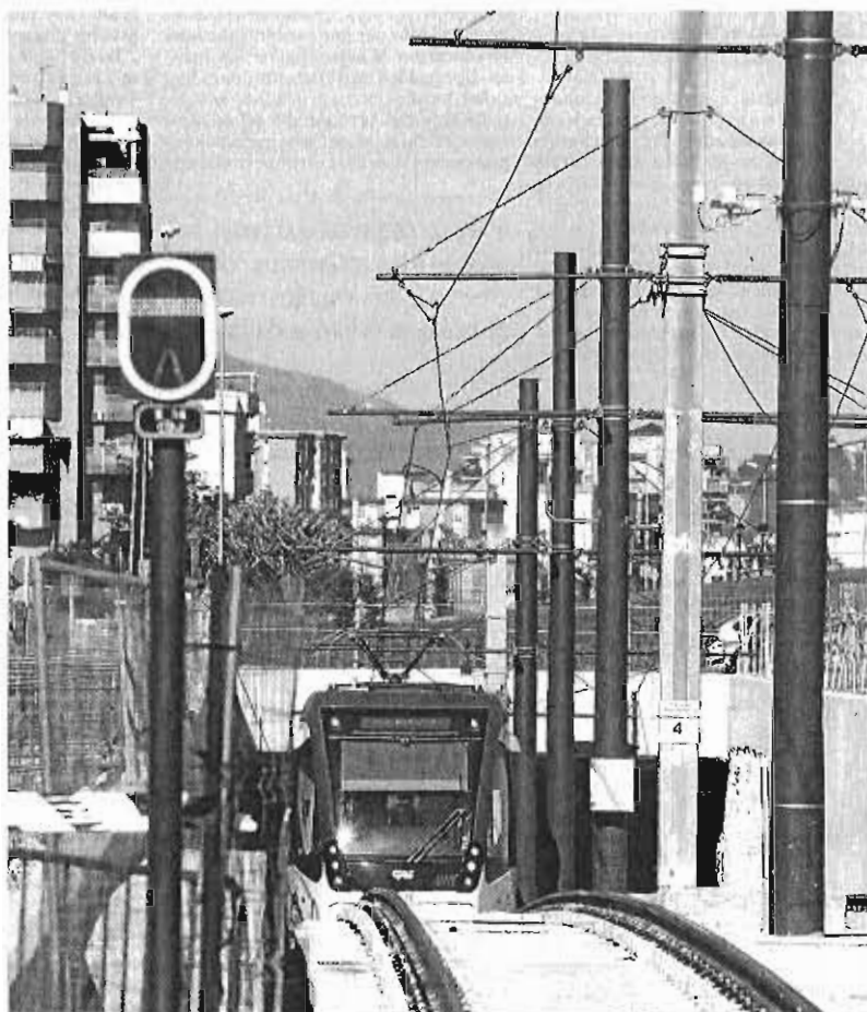
Salida de uno de los trenes del Metro al tramo en superficie de la Universidad.
