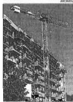
Un edificio en construcción.
