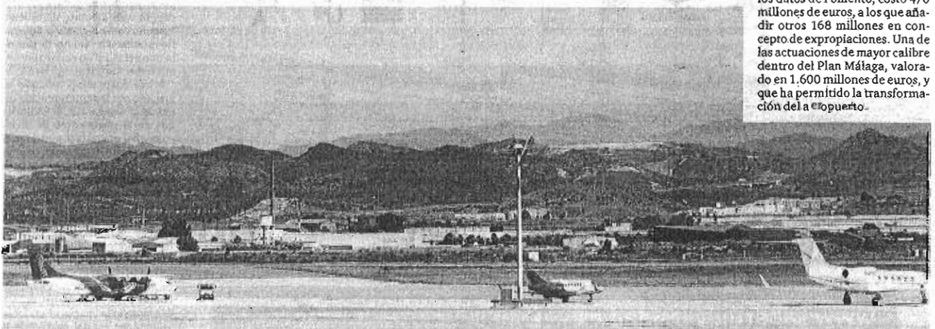
Imagen de la zona de la segunda pista del aeropuerto de Málaga.
