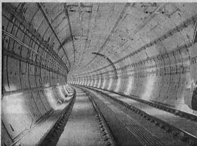
Túnel de la segunda pista del Aeropuerto de Málaga, proyecto desarrollado por Sando.
